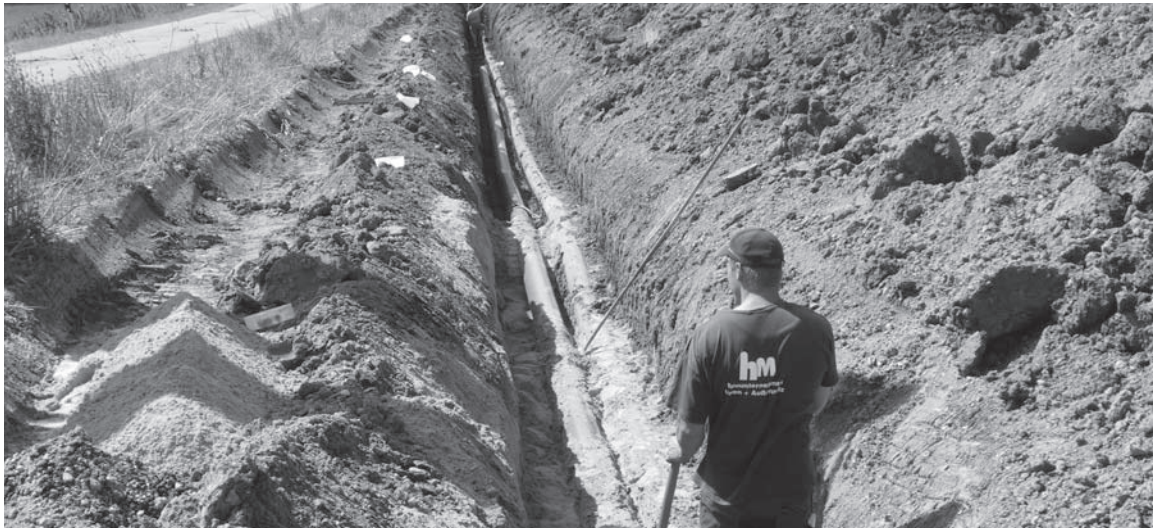
Ernormer Aufwand ist nötig, um eine Wasserleitung zu erneuern.
